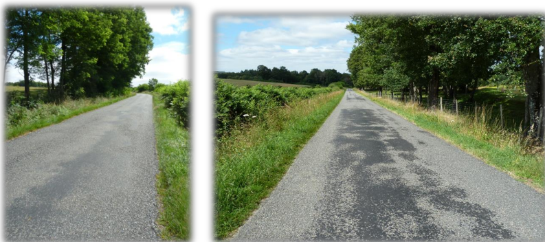
La RD 34 au droit de l'AEI
